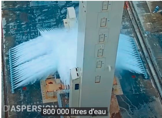
Figure 1. Système de déluge de la zone de lancement d'Ariane 6 (vidéo du CNES)
