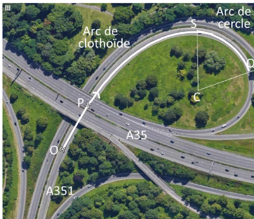
Figure 3. Vue aérienne partielle de l'échangeur de Cronembourg, Bas-Rhin ; coordonnées : 48^{\circ}35'02.9''N , 7^{\circ}43'31.8''E
